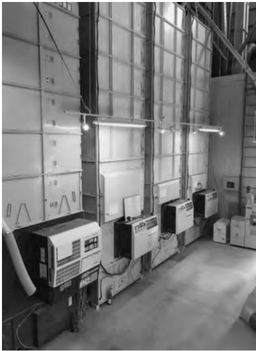
新たに建設された建物内には、穀物乾燥機が並ぶ
